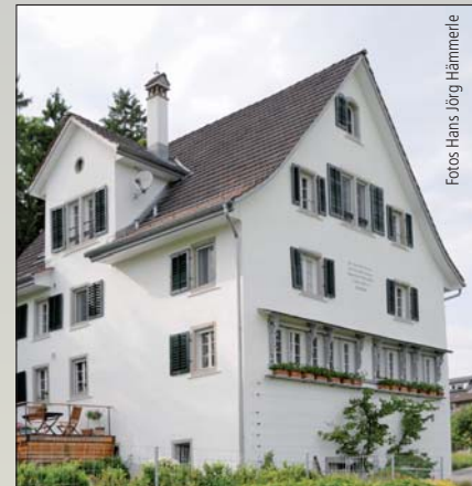
Renovierte Fassade mit Schriftdekoration
